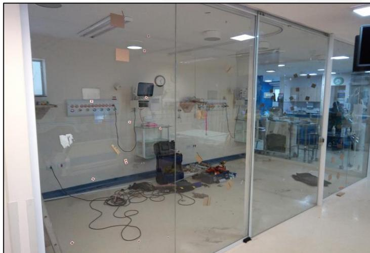
Relevante reforma em andamento contemplará os 28 apartamentos da Ala E, num total de 56 leitos, abrangendo substituição dos revestimentos, das instalações elétricas, telefonia, chamada de enfermagem, hidráulicas, implantação da rede de água quente, substituição das esquadrias, adequação dos banheiros para acessibilidade segura e substituição do mobiliário, contemplando expurgo e banheiro para funcionários, obra também finalizada no início de 2.022.
